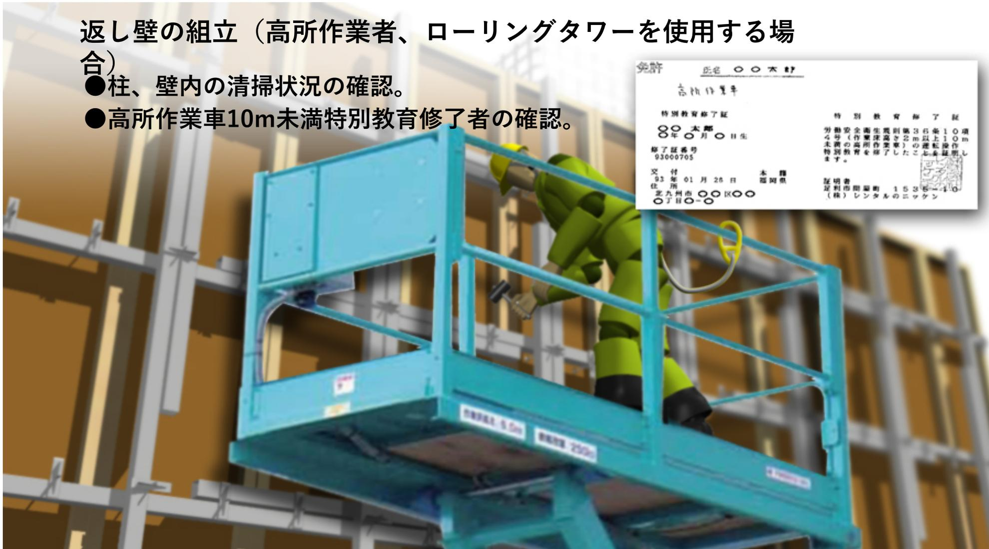
返し壁の組立（高所作業者、ローリングタワーを使用する場合）
